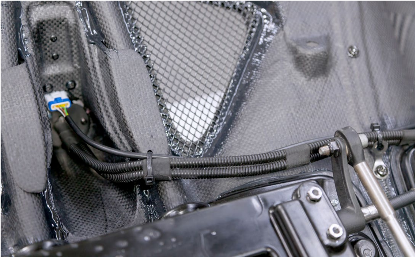
Kabel verlegen und befestigen. / Route the harness and affix it.
